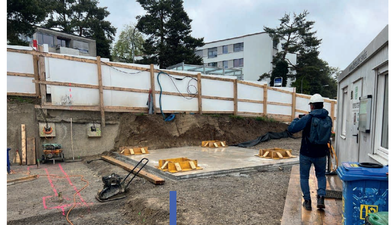
Fundament für den einen der zwei Baukräne
